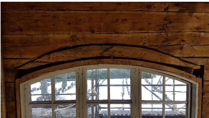
Urkuparven länsiseinän ikkunan päälle tehty paikka, joka jää hivenen mysteeriksi.
